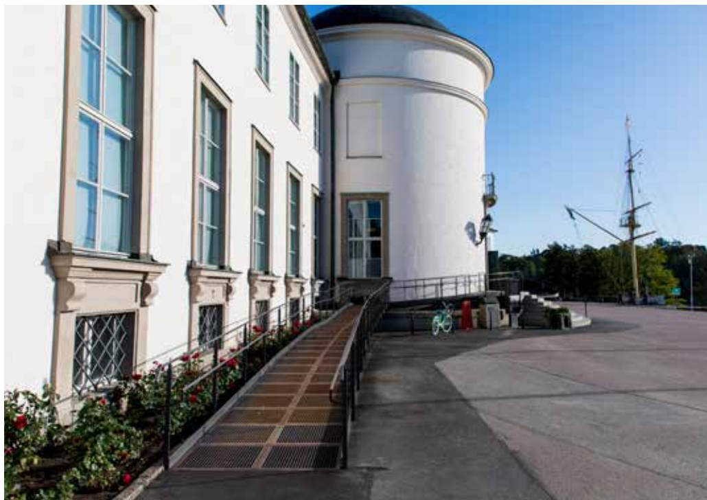
Rampen till Sjöhistoriska Museet på Djurgården i Stockholm är byggd med Siggesta markgaller som lämpar sig väl för att skapa hörnor och olika former.
