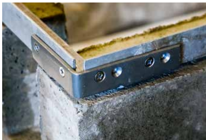
Varmförzinkat plattstål. Ramen kommer i delar som monteras på plats.
