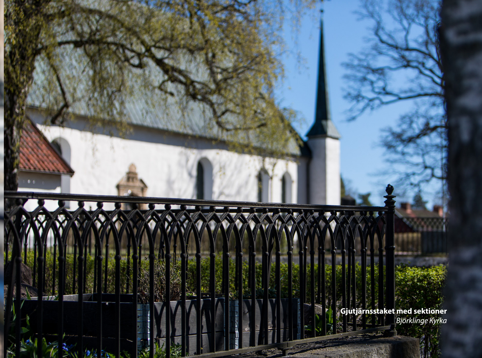
Gjutjärnsstaket med rörstolpar och fallnät Svartån , Västerås
