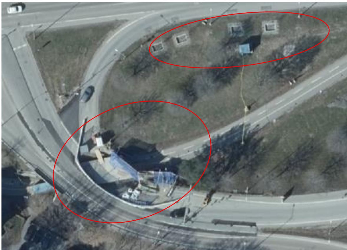
Figur 17 Vy renovering GC-tunnel.
